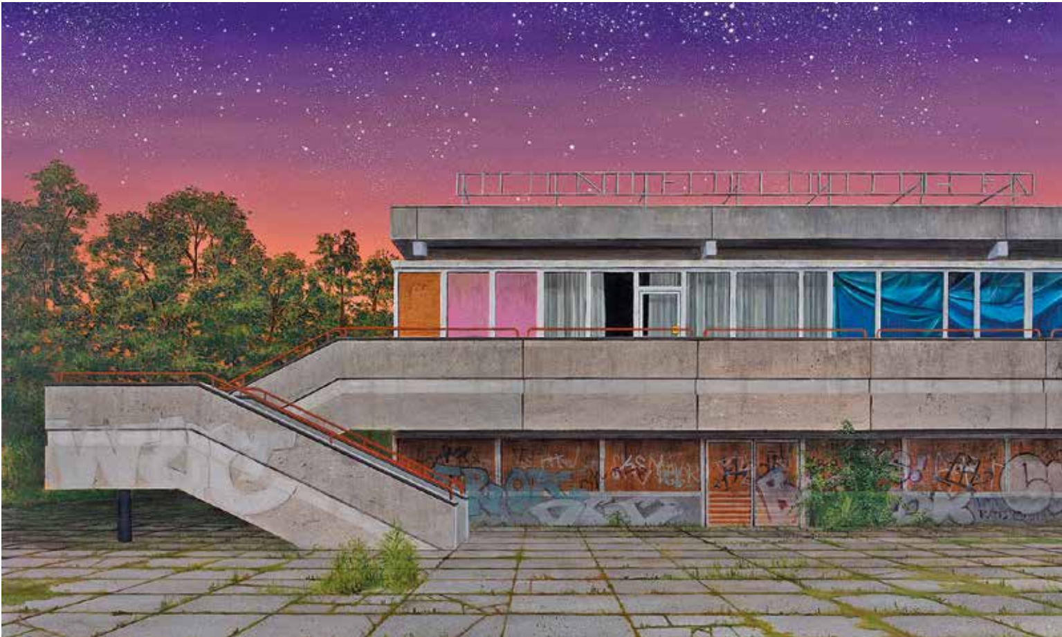
Ein Plattenbauwürfel, der einst eine Wohngebietsgaststätte beherbergte, ist zu einem verlassenen, traurigen Ort geworden.
